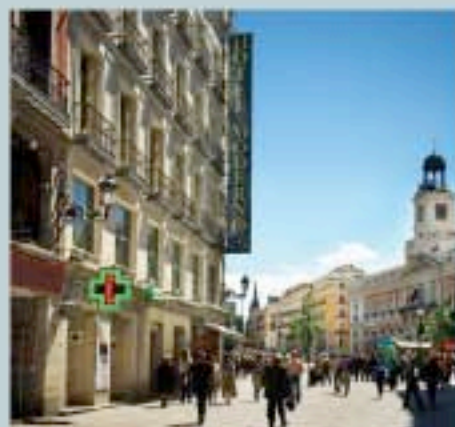
Fachada del hotel.
